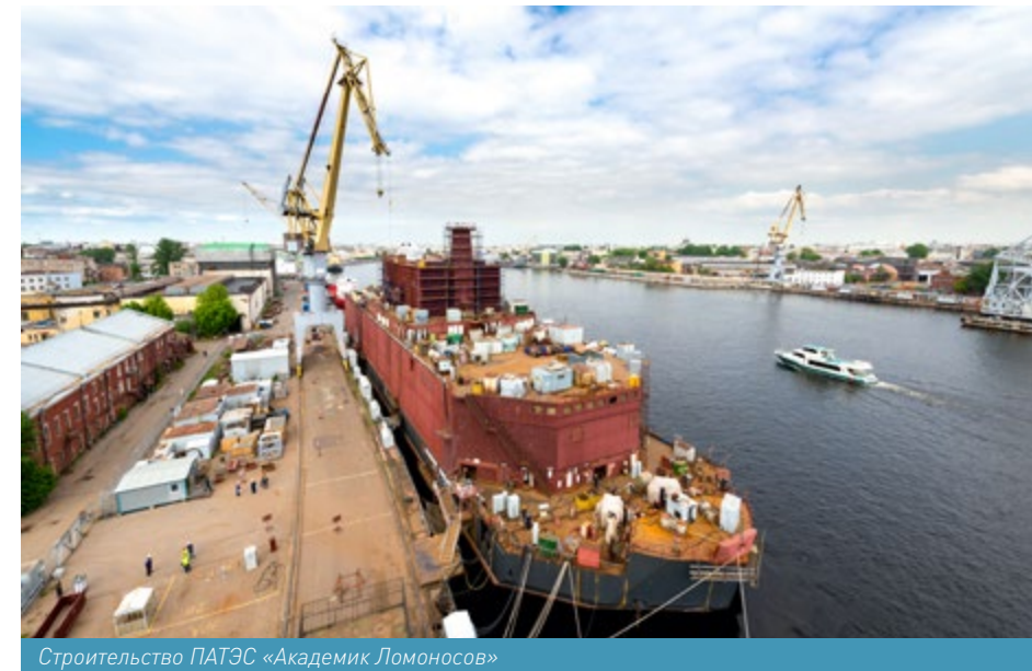
Строительство ПАТЭС «Академик Ломоносов»
