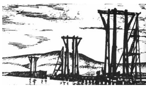
Копры для забивки свай во время строительства моста 1944 год.
